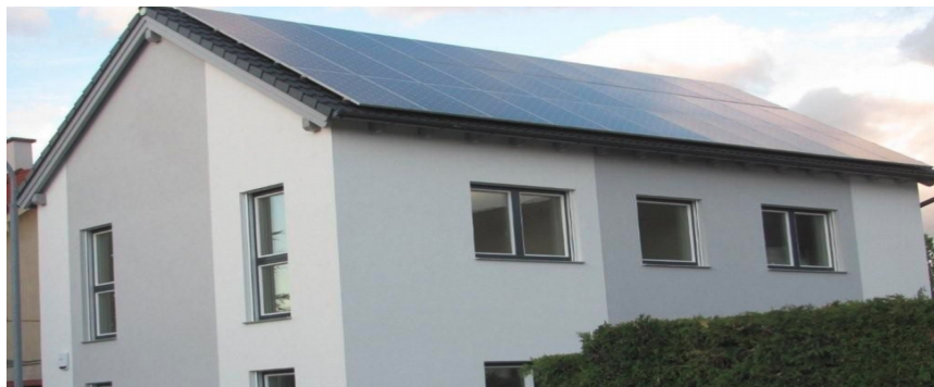
Abbildung 12.15: Dezentrale Solarstromanlage in 1023 Wien ("Plus-Energie-Haus") [162]
